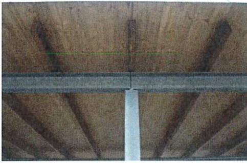
Carport mit Brettschichtholzplatten und einer Stahlkonstruktion
