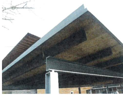
Carport mit Brettschichtholzplatten und einer Stahlkonstruktion
