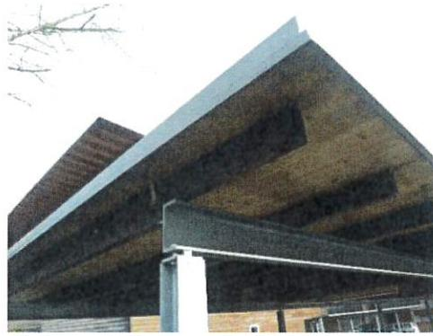
Carport mit Brettschichtholzplatten und einer Stahlkonstruktion
