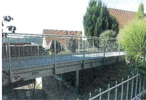
Terrassen und Brücke mit einfachem, transparenten, stabförmigem Metallgeländer.
